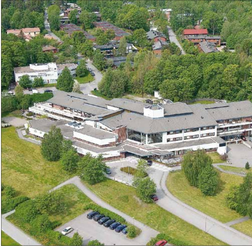
Oulunkylän kuntoutussairaala sijaitsee vehreän Itsenäisyydenpuiston länsilaidassa.
